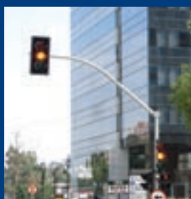
POSTE CÔNICO CONTÍNUO DE AÇO PARA SINALIZAÇÃO SEMAFÓRICA
